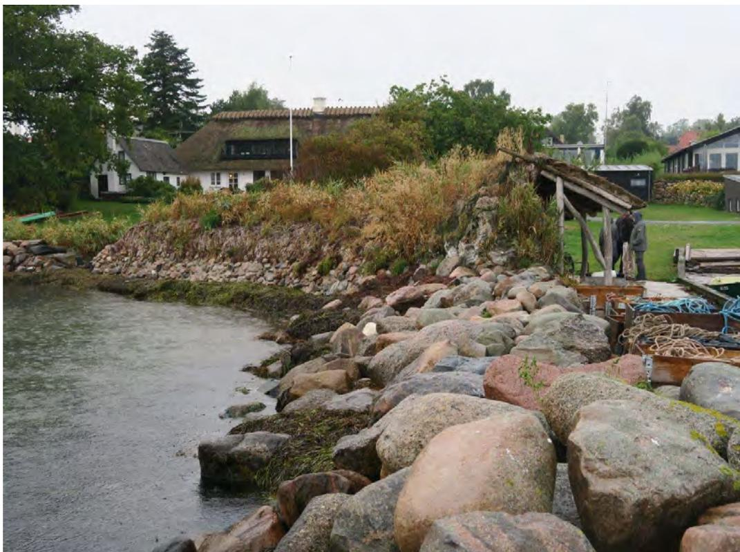
Abb. 9: Tangdige auf Steinunterbau am Kustenfischerplatz Fiskop/Fyn. Der rechts integrierte Unterstand mit Reetdach ist gegen von Westen (links) kommende Brandung gut geschutzt. (Foto: Michael Packschies)
