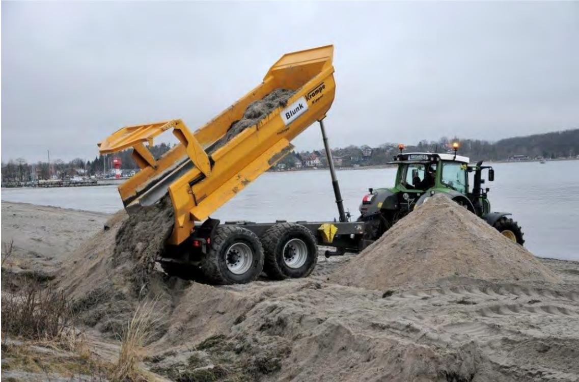
Abb. 6: Der Graben wird mit Seegras verfüllt und anschließend mit dem ausgehobenen Sand überdeckt. (Foto: Michael Packschies)
