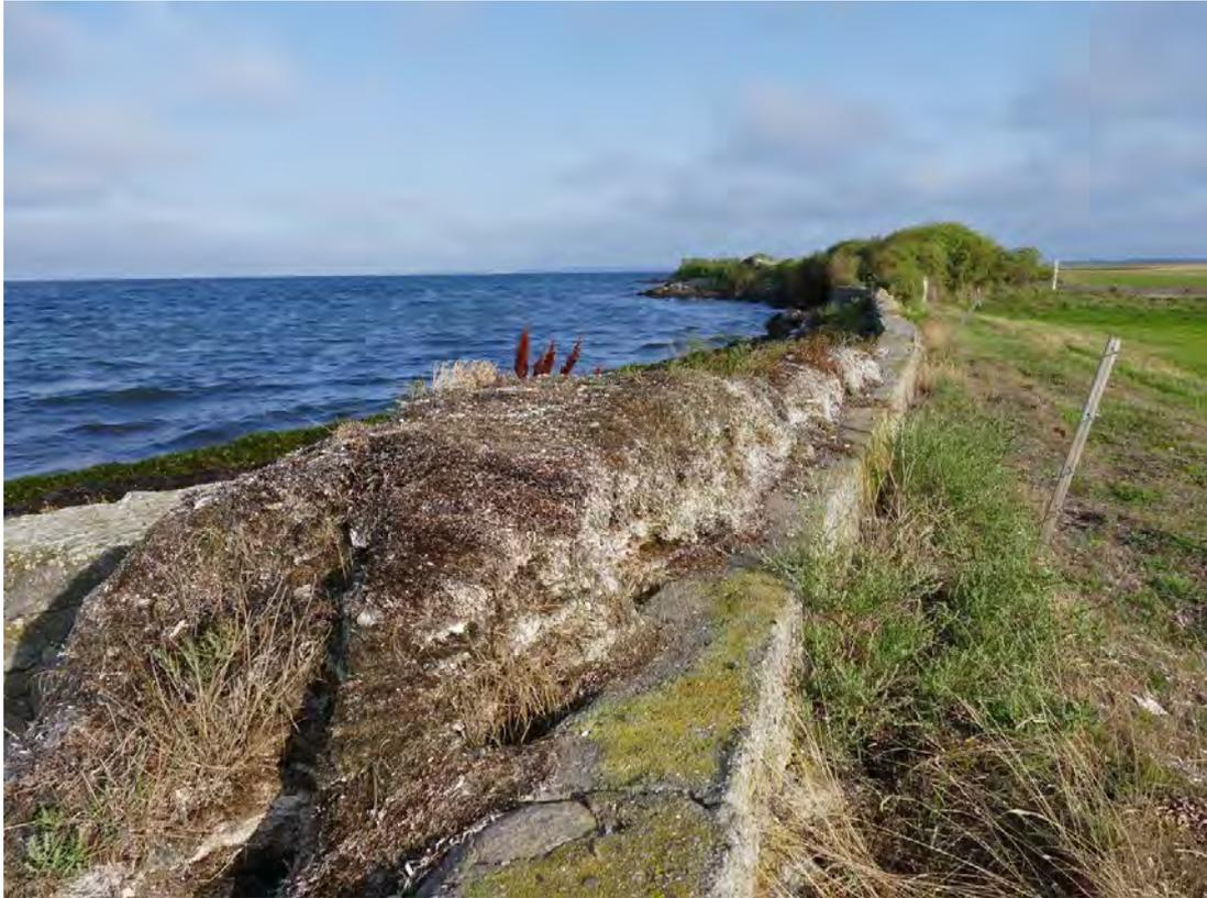
Abb. 8: Mit Steinmauer kombinierter Tangdige an der Sudwestkuste von Skaro. Im Hintergrund sind mit Bocksdorn uberwachsene Abschnitte zu erkennen (Foto: Michael Packschies)
