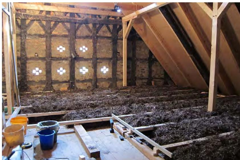
Abb. 7: Gerade bei alten und historischen Häusern ist häufig die Obere Geschossdecke nicht gedämmt. Hier braucht Seegras nur verteilt zu werden. Will man den Dachboden später noch nutzen, kann man auch eine Holzfaserverplatte oder Bretter oben drauf anbringen. (Foto: Simone Walter)
