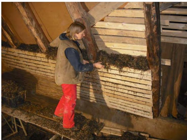
Abb. 8: Will man den Dachboden nutzen, muss man die Dachschräge dämmen. Das ist sowohl nachträglich, bei einer Neueindeckung des Daches, als auch bei einem Neubau möglich. (Foto: Jörn Hartje)
